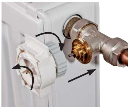
4.2 Pomocí vhodného šroubováku otočte páčku HD13 směrem nahoru a vysuňte převodovou část z těla hlavice.
