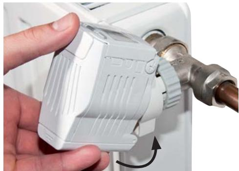
4.5 Pomocí vhodného šroubováku otočte páčku HD13 směrem k ventilu, pro dokončení montáže.
